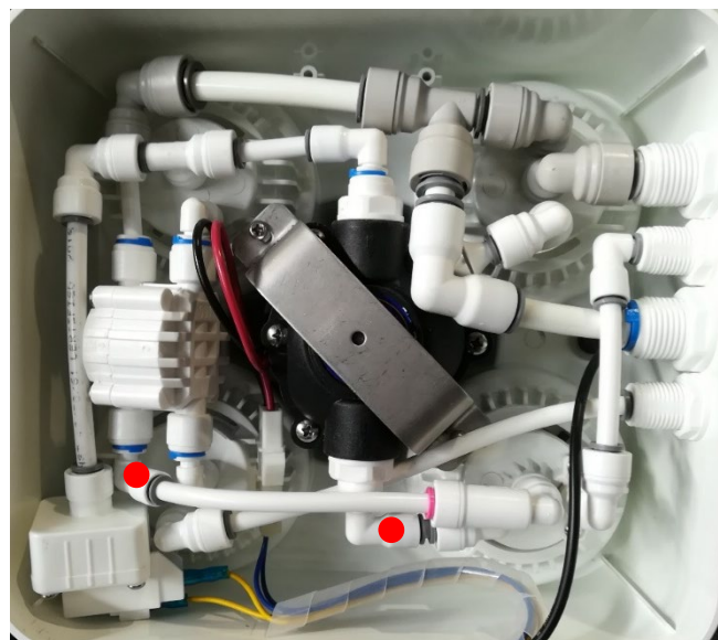
Figure 14 Réalisation du by-pass de la membrane
